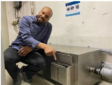
Emanuel Oyeeye, LuckyLunch Kempten nach der Installation des FiltaFOG Cyclone
