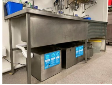
Bild 2: Der FiltaFOG Cyclone ist momentan der Fettabscheider mit der höchsten Fettrückgewinnung – hier zwei Geräte in Kombination
